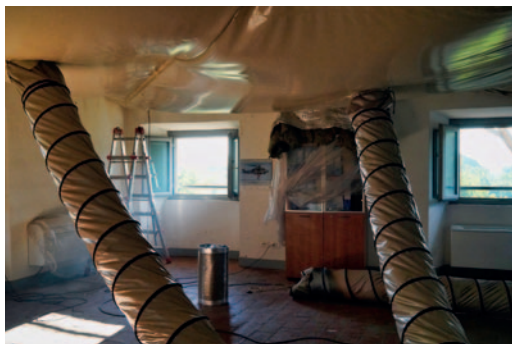
Figura 10 - Disinfestazione termo-induttiva.
