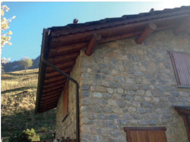
Figura 7 - Travi esterne sotto-gronda.
