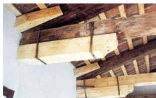
6) Restauro e manutenzione
