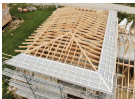
Edificazione lignea senza copertura
